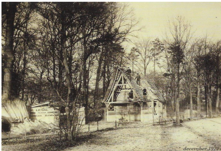
Batakhuisje in aanbouw 1929
